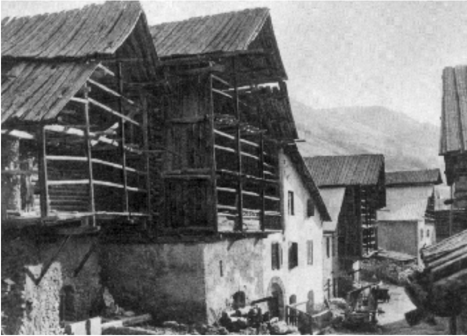
Des "Fustes" subsistent, nombreuses, à Moline et à St-Véran (Fuste du latin fustis=poutre, bois)
