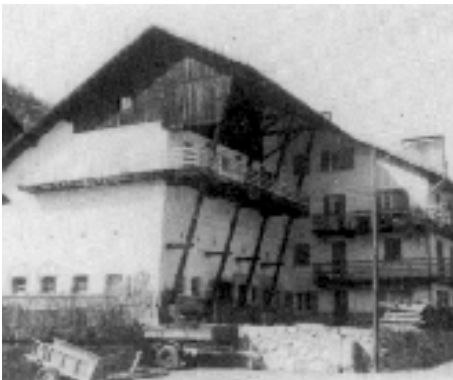
Maison d'Abriès. Habitation et ferme. Reconstruction de 1945
